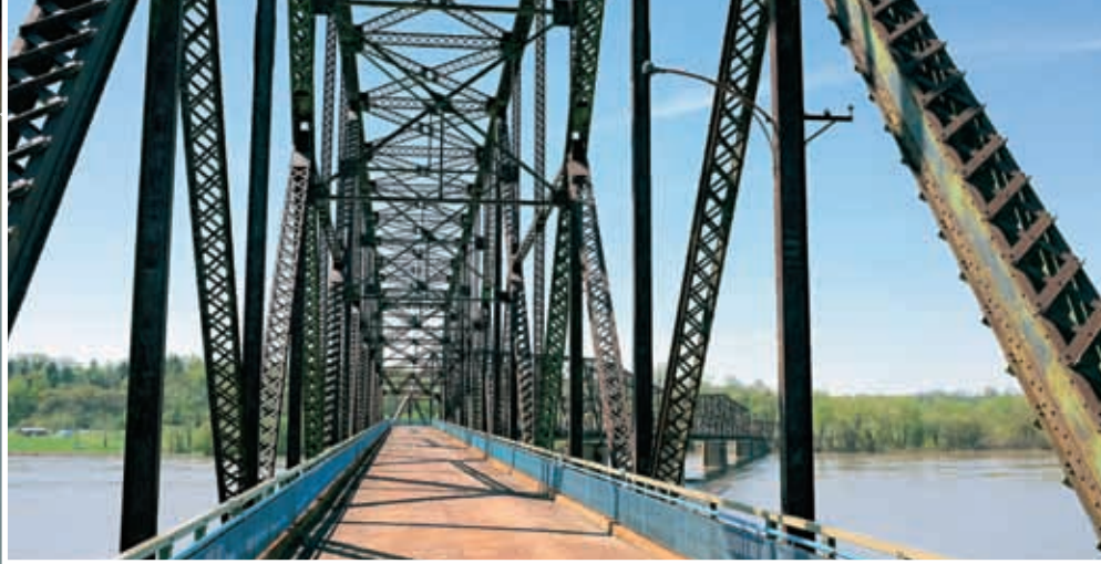
De Chain of Rocks Bridge over de Mississippi, met de kenmerkende knik in het midden, was vroeger een belangrijk punt op Route 66, tegenwoordig mogen er enkel nog voetgangers en fietsers overheen.
